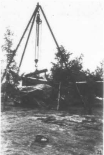
Mit Reparaturen und Instandsetzungsarbeiten gibt es immer alle Hände voll zu tun. Auf dem unteren Bild ist gerade ein Motor mit dem Kran von der Maschine abgehoben worden.
